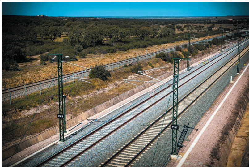
Trabajos electrificación vía de la Línea Alta Velocidad extremeña
